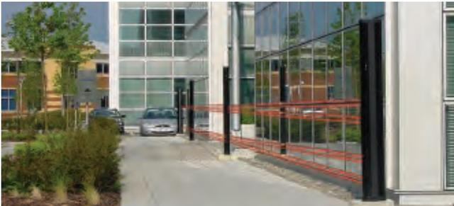
Lichtschranken bestehen aus einem Sender-/Empfängerpaar, bei dem der Sender kontinuierlich Infrarotstrahlen an den Empfänger schickt und einen Alarm auslöst, wenn die Übertragung unterbrochen wird. Diese Art der Erkennung ist selbst in warmen Ländern, in denen die Lufttemperatur und die Körpertemperatur eines Menschen ungefähr gleich sind, sehr präzise.
