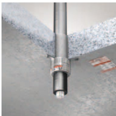
ZZ-Manschette in Massivdecke mit Getränkepythoneinleitung einseitig aufgesetzt
