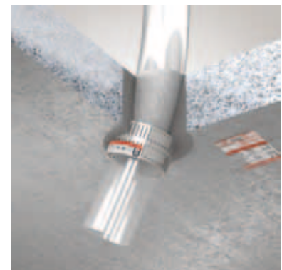
ZZ-Manschette in Massivdecke mit Rohrpostbogen einseitig eingesetzt
