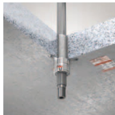
ZZ-Manschette in Massivdecke mit Mehrschichtverbundrohr einseitig aufgesetzt
