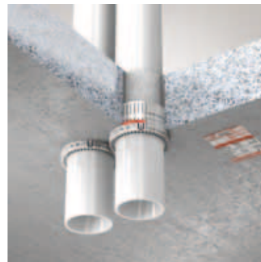
ZZ-Manschette in Massivdecke mit Nullabstand einseitig eingesetzt
