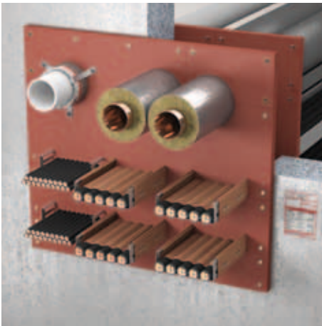
System ZZ-Platte BDS-N in Massivwand aufgeschraubt
