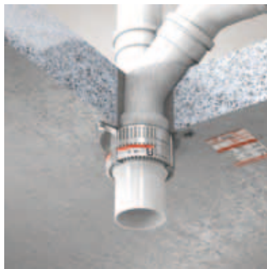
ZZ-Manschette in Massivdecke mit Muffe einseitig aufgeschraubt
