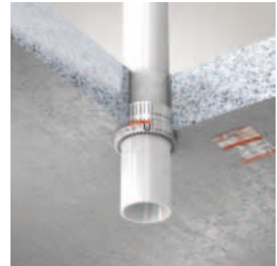
ZZ-Manschette in Massivdecke einseitig eingesetzt
