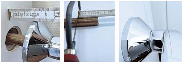
Sie brauchen nur noch ein Maß nehmen, auf dieses Maß anpassen und montieren. Kein Gewinde an der Armatur mehr sichtbar.
