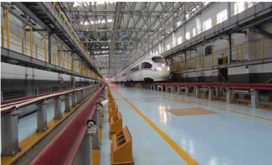
Zugenteisungsanlage mit FÖHN Wärmeluftherzeuger
