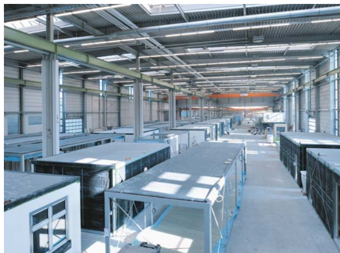
3 Vorfertigung in der Raumfabrik
