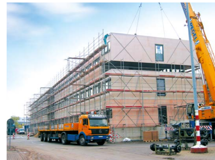
5 Montage der Module
